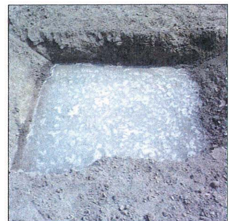
Figura 14 - La fase di imbibizione precedente alla prova di carico su piastra
